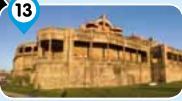
13 PUNTA BEGOÑA GALERIAS | GALERIAK GALLERIES | GALERIES
